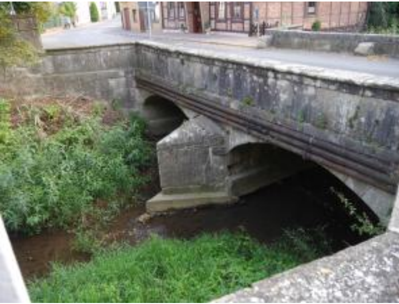
Die historische Brücke am 03.09.2018
