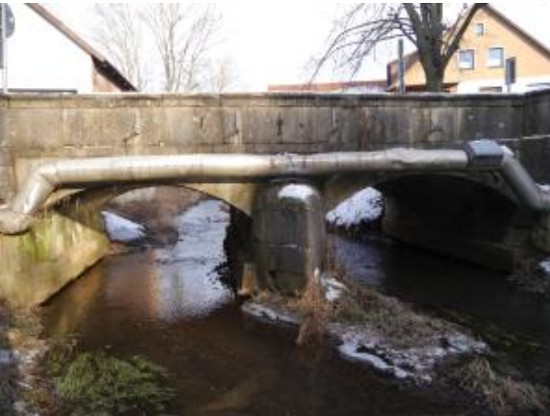
Die historische Brücke am 27.01.2017
